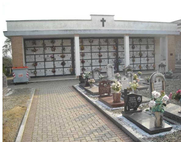
Foto 6. Loculi con frontone e rivestimento in paramano
